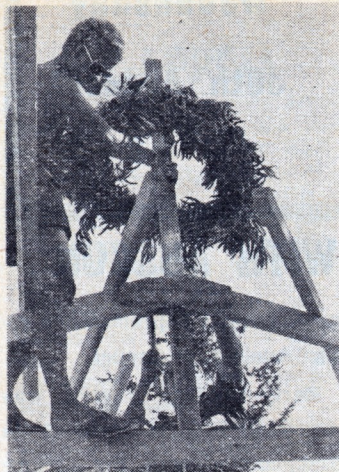
●Rejsegilde på det nye posthus. KS P. Pedersen og KS B. Knudsen er igang med at fastgøre kransen.
