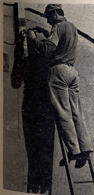
Sähkömies Suomalaisella riittää töitä, sillä tällaiset johdot alkavat olla jo hylkytavaraa, joten vikoja aina löytyy, varsinkin sateella.
