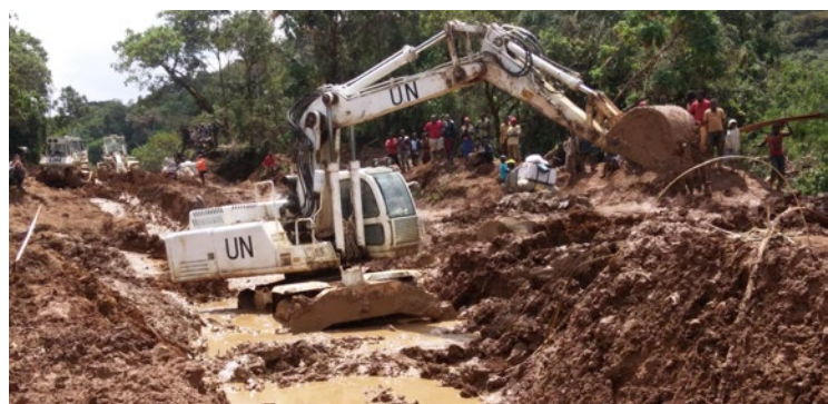
Réhabilitation de la route entre Dungu et Duru
